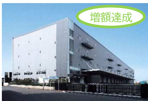
市川ロジスティクスセンター (千葉県市川市)
