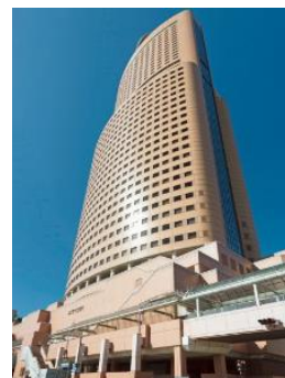
浜松アクトタワー
