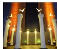
浜松アクトタワー
