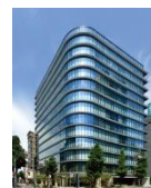
ORE錦二丁目ビル
